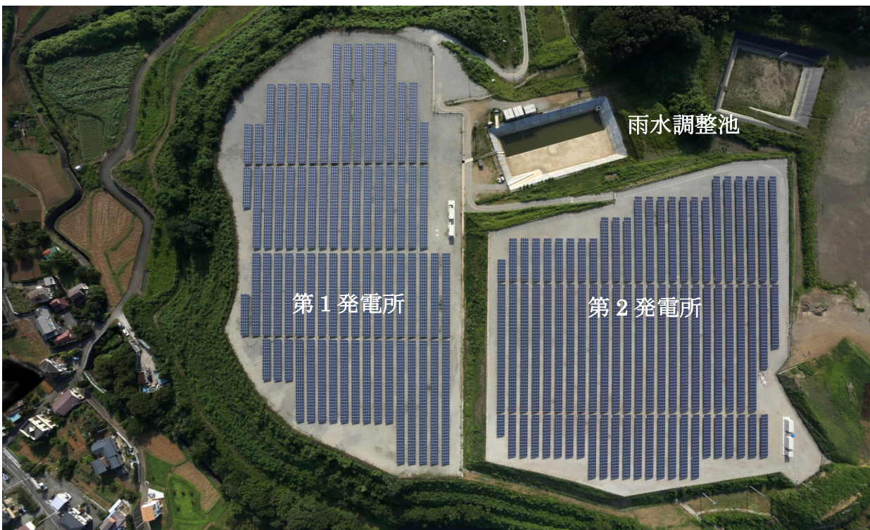
厚木太陽光発電所（全景）
